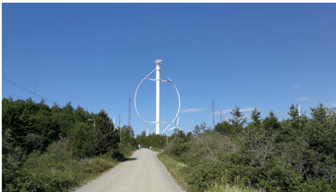
Éole – ветрогенератор с вертикальной осью вращения
