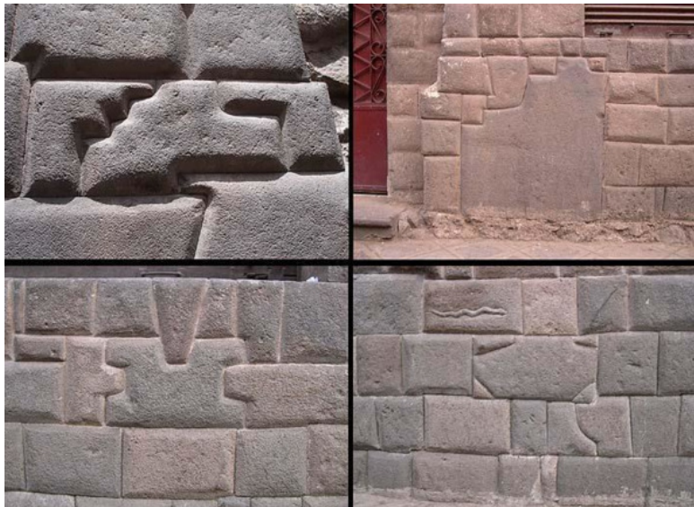
Рис. 43. Полигональные вставки из прямоугольных блоков
