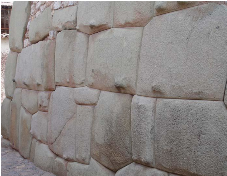
Рис. 42. Выступы на блоках полигональной кладки [155]
