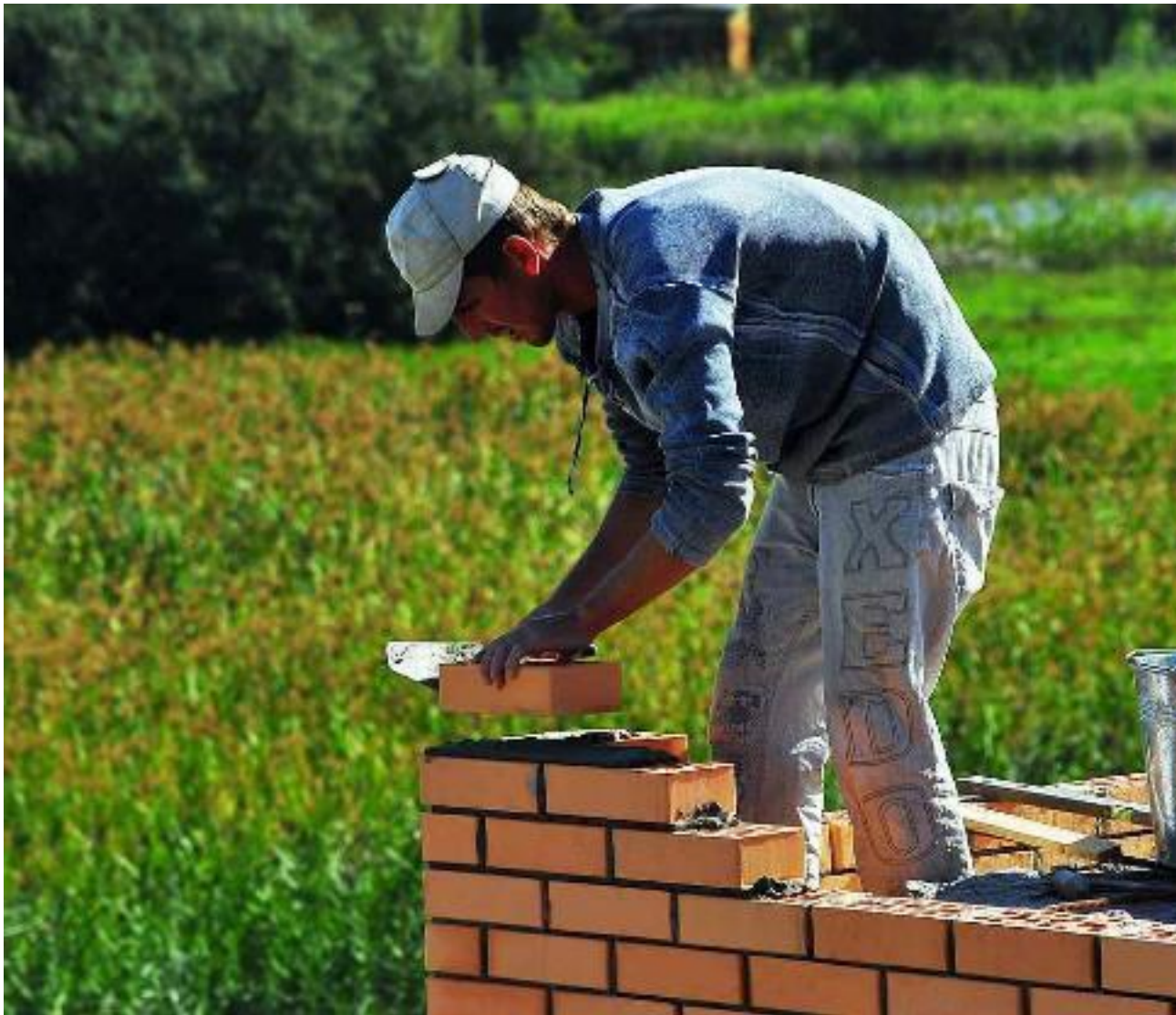
Fig. 1.1.8 As de Oros: incremento de las Materias. Un albañil coloca un ladrillo en un muro de ladrillos.
