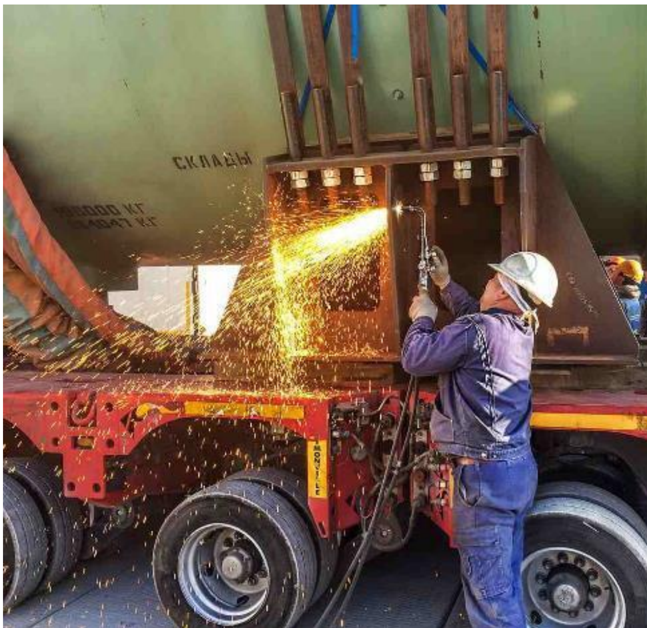
Ilustración 1.7.3 Siete de Oros: eliminación de todo lo superfluo en las Materias. Soplete autógeno. Cortadora de gas. Por lo tanto, la soldadura es el «Siete de Oros» invertido: añadir lo «superfluo» a las Materias. 75
