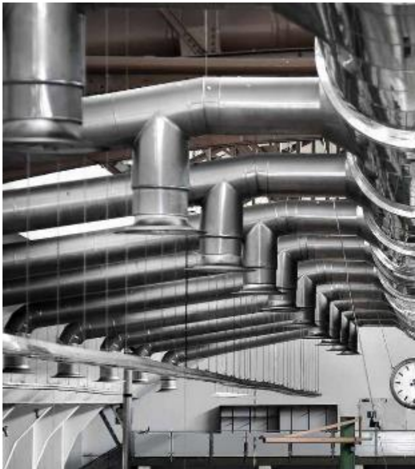
Figura 1.13.3 Rey de Oros – Guía del Poder de la Materia. Red de calefacción. Calefacción por vapor. 128
