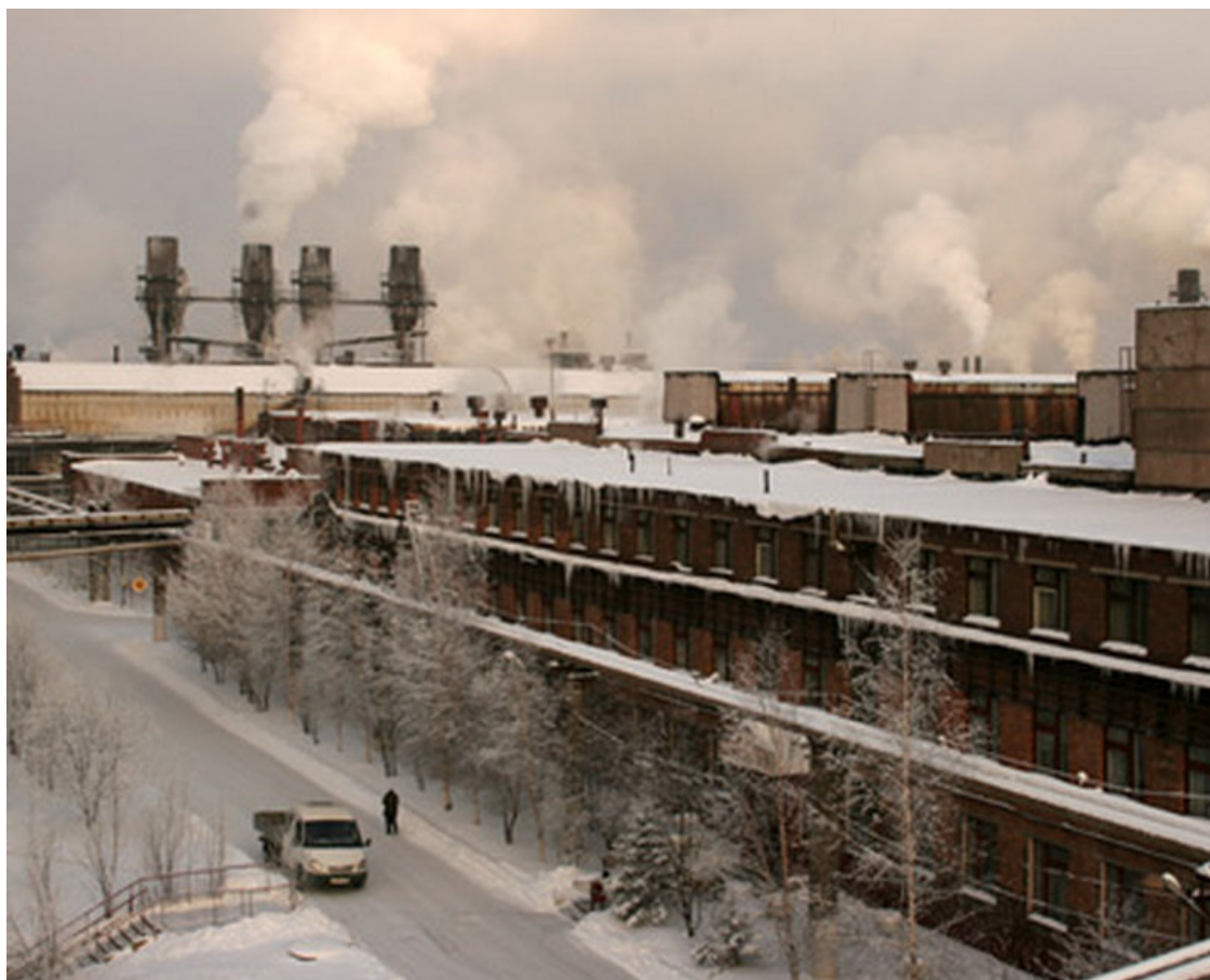
Завод котельных радиаторов.
