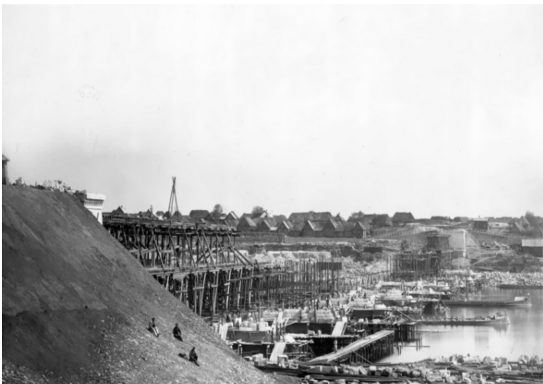
Коломна, 17 мая 1864 г. Строительные работы второго периода начались
