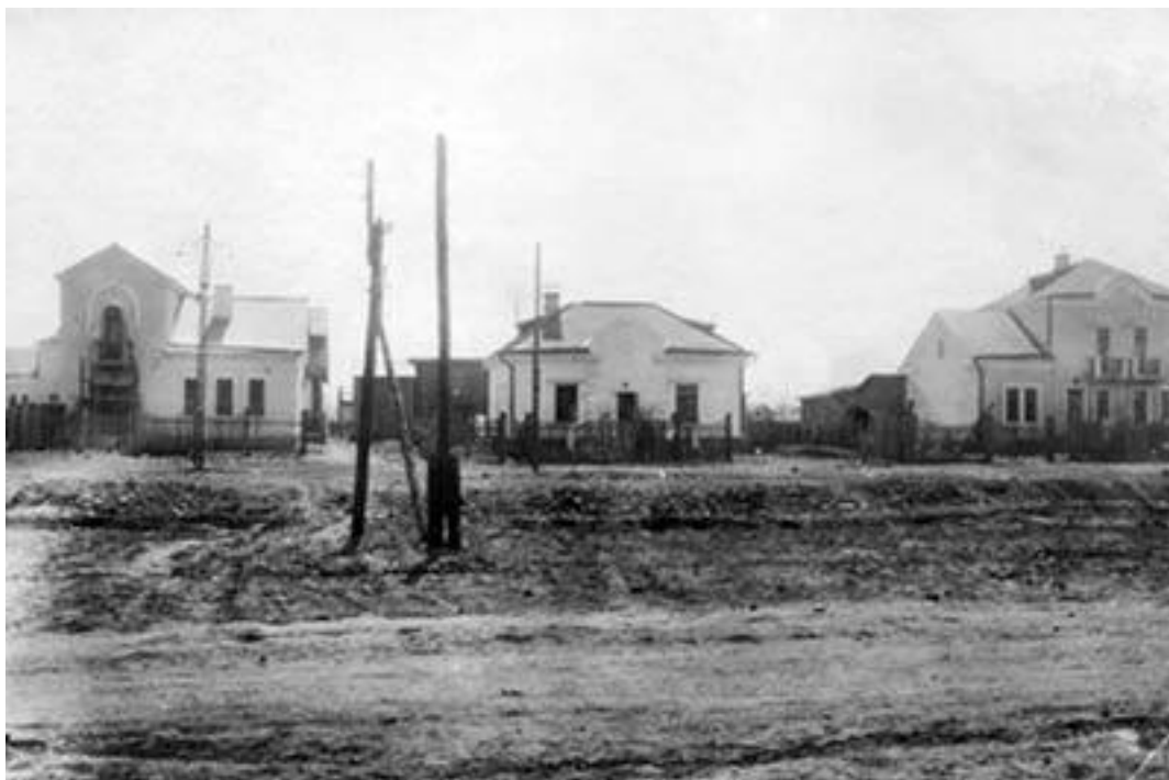
Возведение коттеджей для руководящего состава авиазавода
