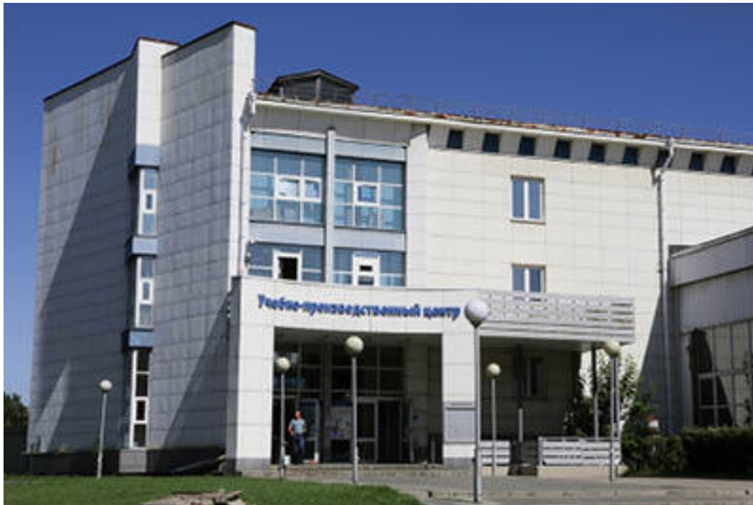
Учебно-производственный центр ИАЗ
