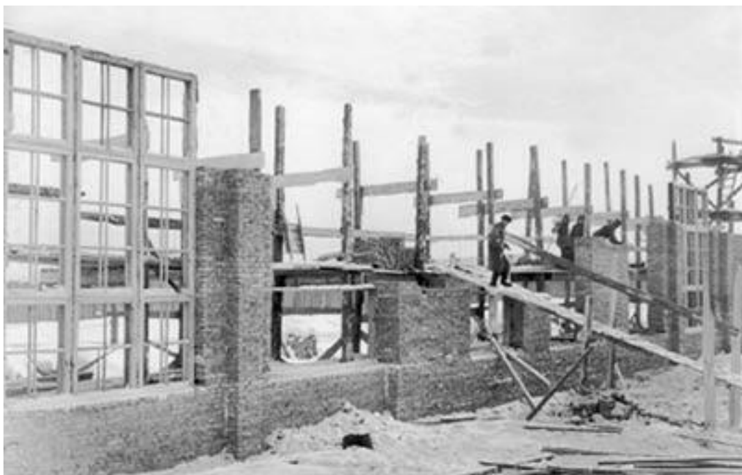
Строительство основного корпуса
