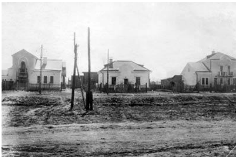
Возведение коттеджей для руководящего состава авиазавода
