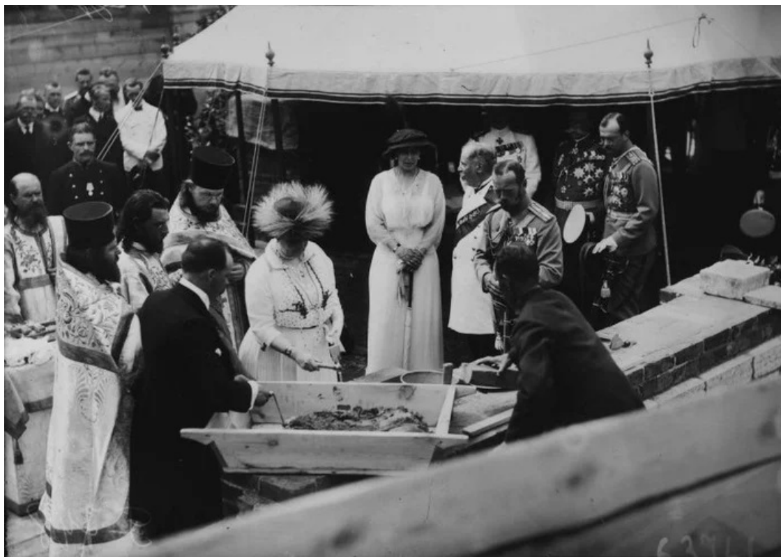
Рис. 21. На строительстве храма Христа Спасителя
