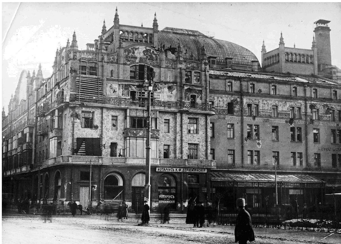
Рис. 45. Разрушения в Москве (гостиница Метрополь)
