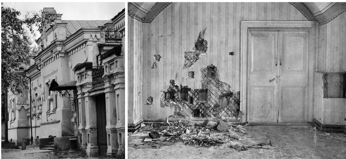
Рис. 137. Дом инженера Ипатьева и подвал в этом доме
