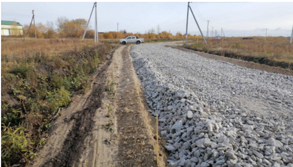
Так выглядит отсыпка дороги
