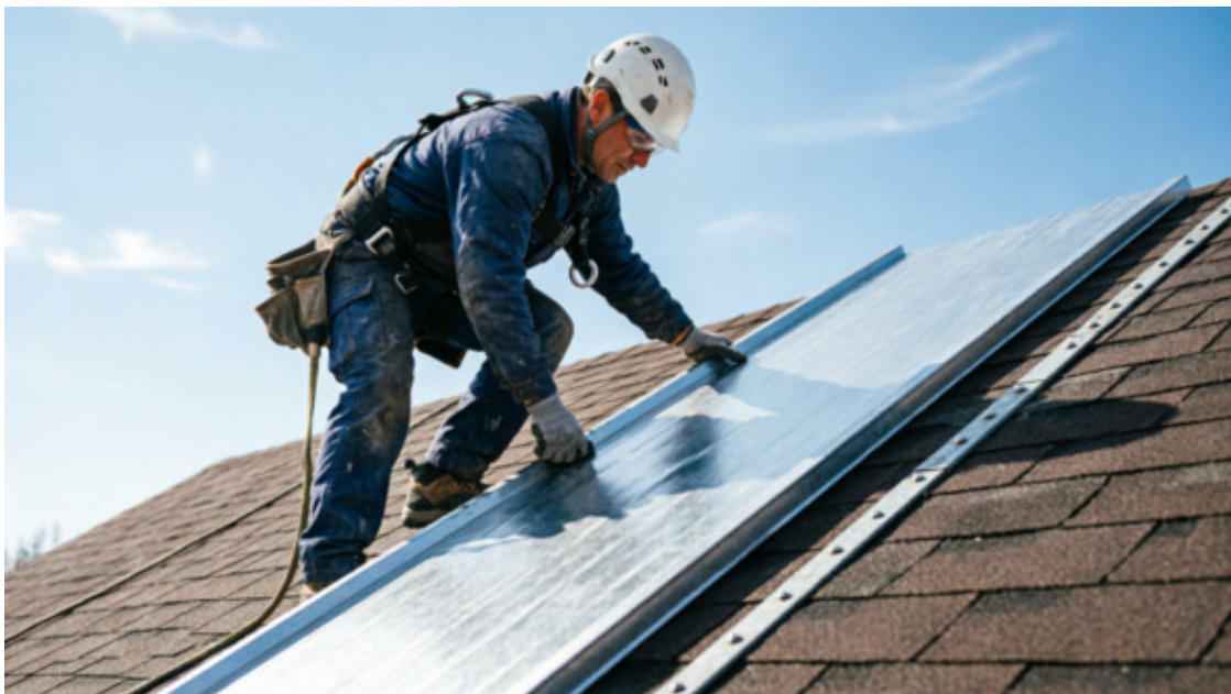
Кровельщик за работой на скатной кровле
