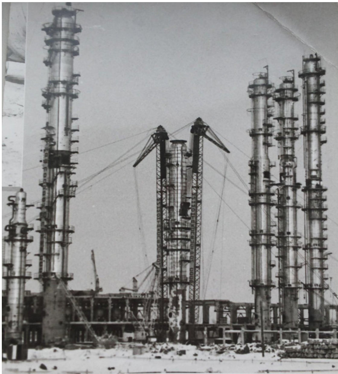
Подъём и установка колонн апрель 1983 г.
