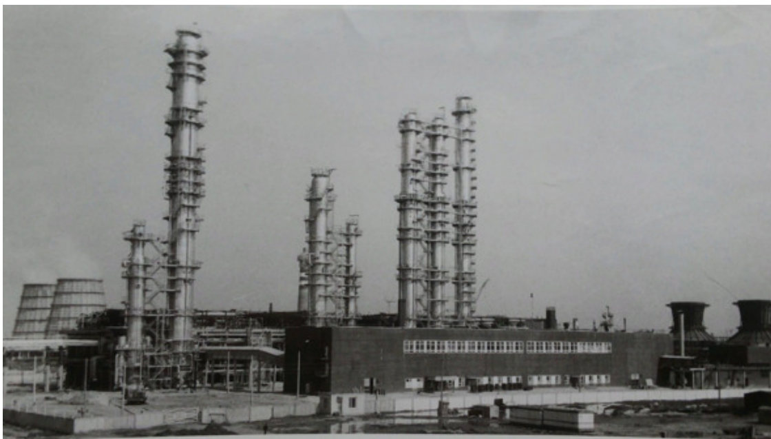
Пуско-наладочные работы на ЦГФУ 1984 г.
