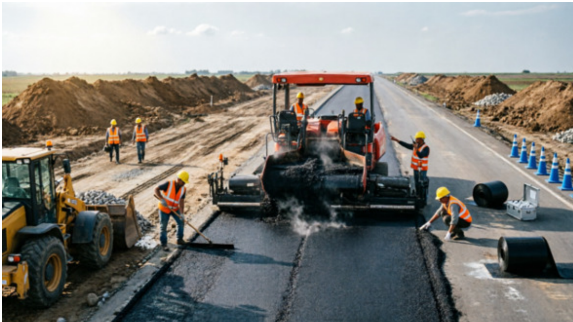
Процесс укладки асфальта с техникой
