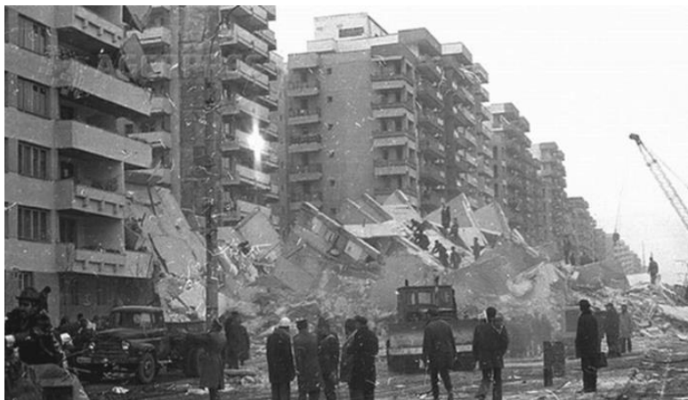
Землетрясение в Бухаресте в 1977 году
