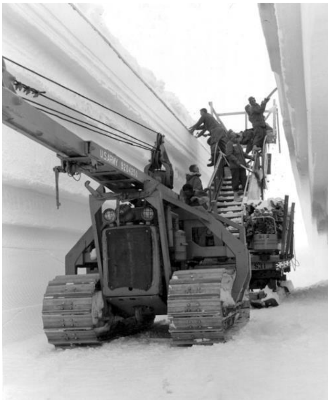
Процесс строительства траншей для базы в Кемп-Сенчури (Гренландия). 1957 г. Фото http://sekretmira.ru/
