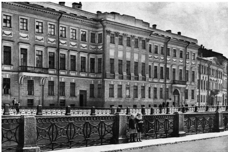
Дом на набережной Мойки, 12. Последняя квартира Пушкина. 1950-е гг.
