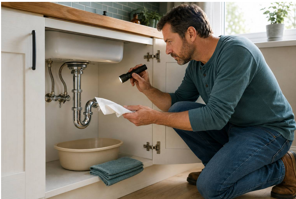
Рисунок 5. Поиск первой капли на предварительно высушенном узле
