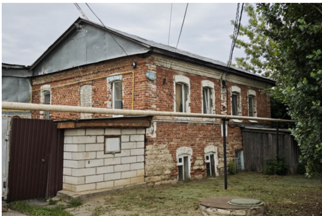
Жилой дом, XIX в. (ул. Комсомольская, 20)
