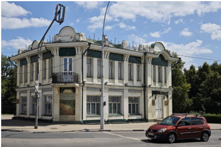
Дом В. К. Вяжлинского, 1910 г. (ул. Ленина, 2)
