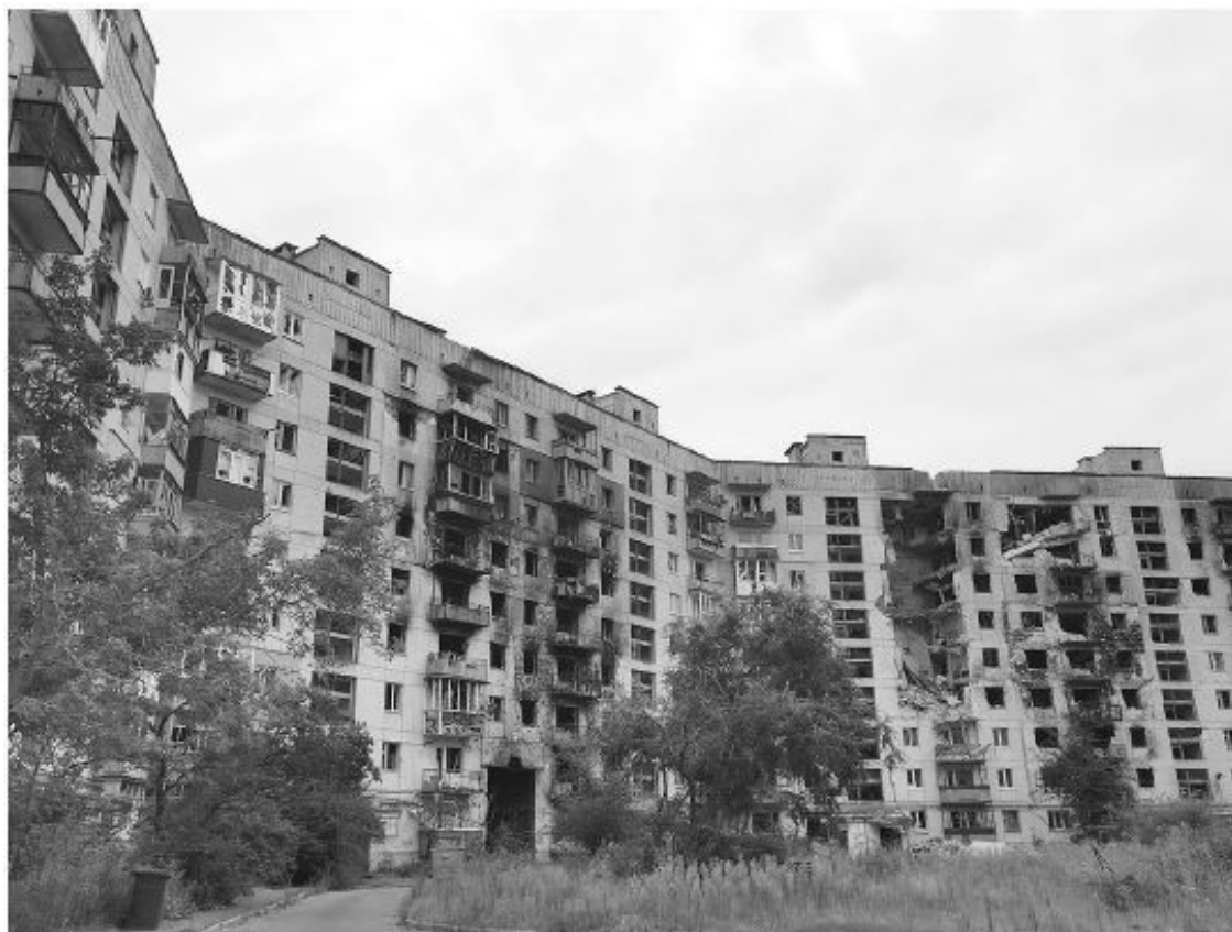
Август 2023 года. Северодонецк. В одном из подъездов этого дома живут люди...
