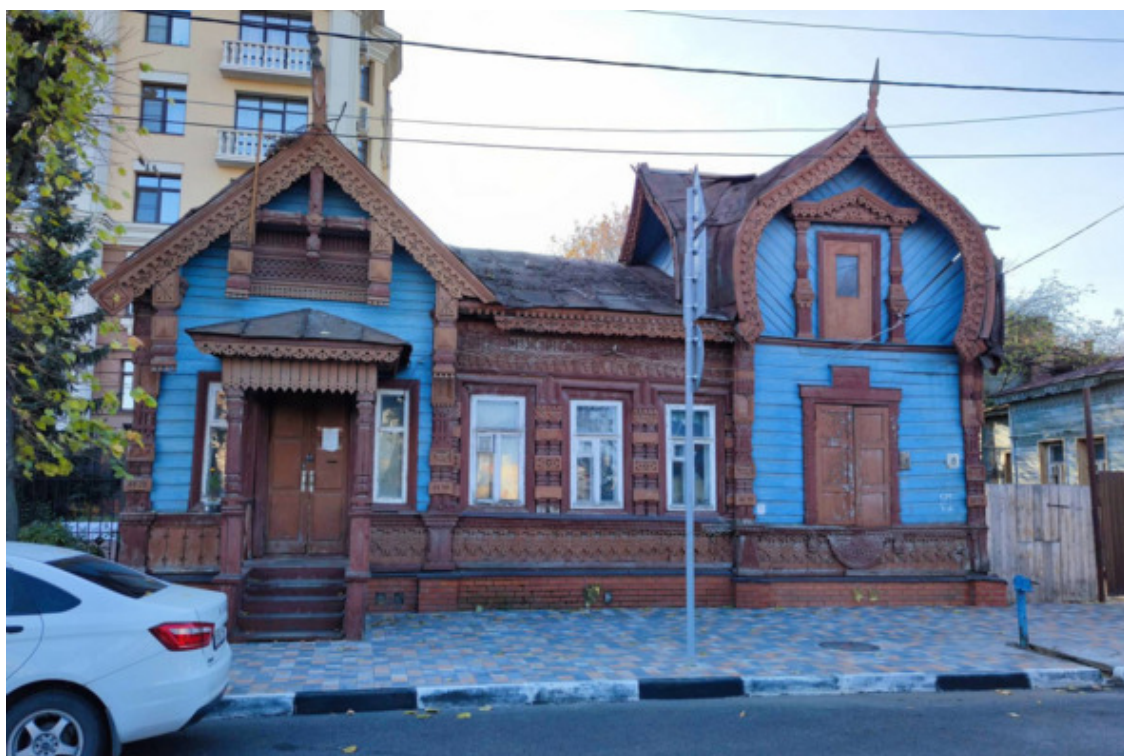
Дом деревянный с резьбой, XIX в. (ул. Щедрина, 19)
