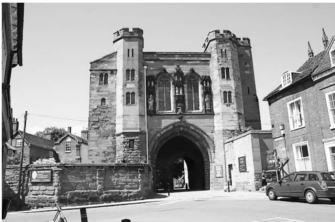
Замок Вустер (англ. Worcester Castle). XIII–XIV вв. Башня Эдгара, ныне вход в Колледж Грин, включает остатки торхауса замка
