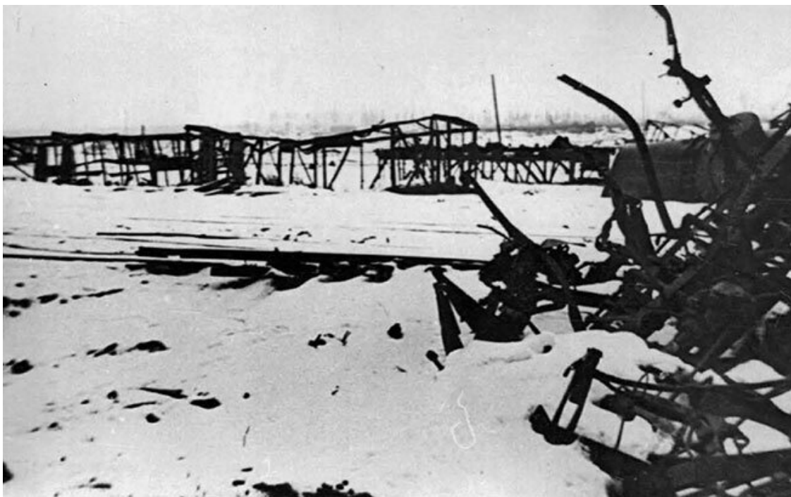
Разрушенная станция Мга после освобождения от фашистов. Фото 23 января 1944 год
