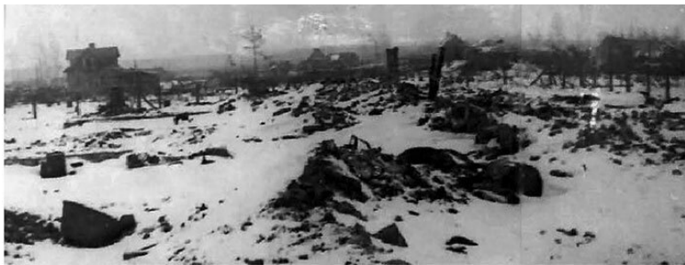
Панорамное фото разрушенного посёлка Мга. 23 января 1944 года
